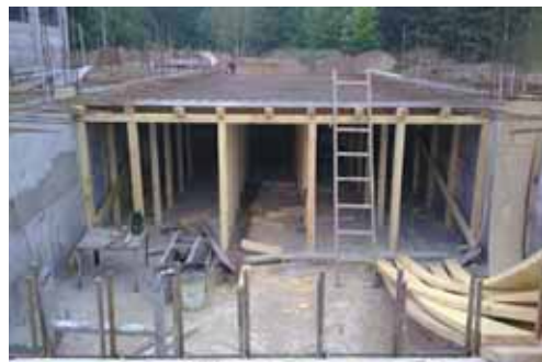
Рис. 5.4. Основные этапы строительства пункта контейнерного хранения низко- и среднеактивных твёрдых радиоактивных отходов: а — возведение металлического каркаса хранилища низкоактивных отходов; б, в — начало строительства технологического корпуса; г, д — закладка основания хранилища среднеактивных отходов и его сооружение; е — внутренние работы в технологическом корпусе
