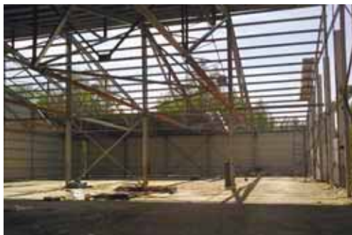
Рис. 5.4. Основные этапы строительства пункта контейнерного хранения низко- и среднеактивных твёрдых радиоактивных отходов: а — возведение металлического каркаса хранилища низкоактивных отходов; б, в — начало строительства технологического корпуса; г, д — закладка основания хранилища среднеактивных отходов и его сооружение; е — внутренние работы в технологическом корпусе
